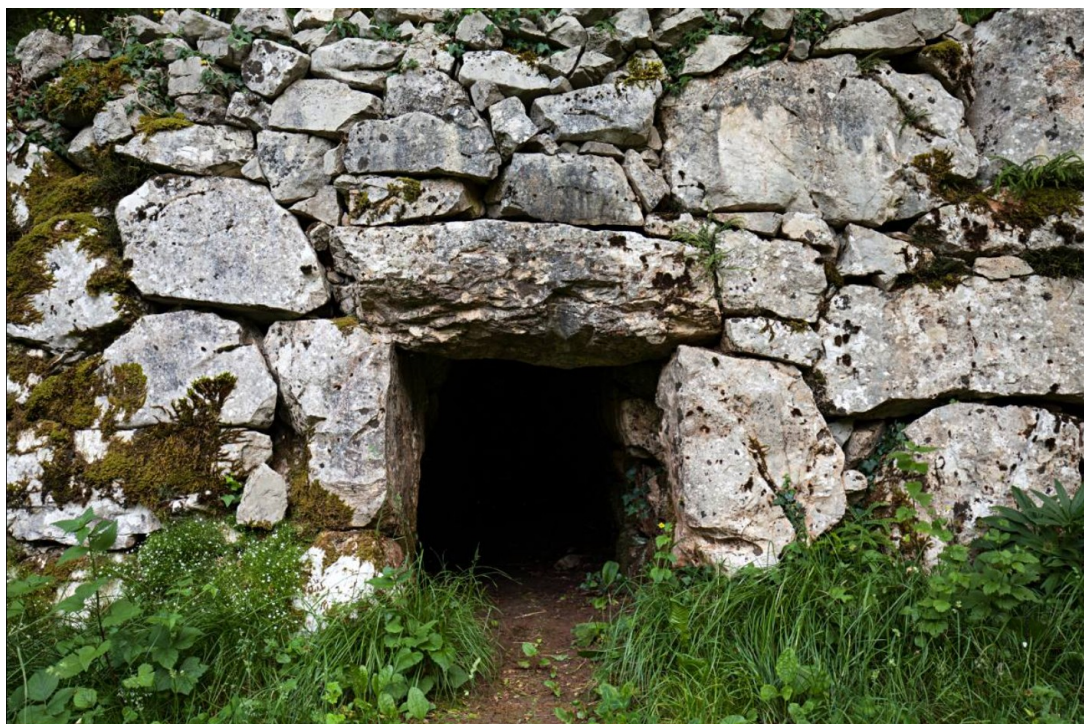
Izredno natančno in premišljeno zložen rov v zidu na dnu vrtače. (foto NN)
