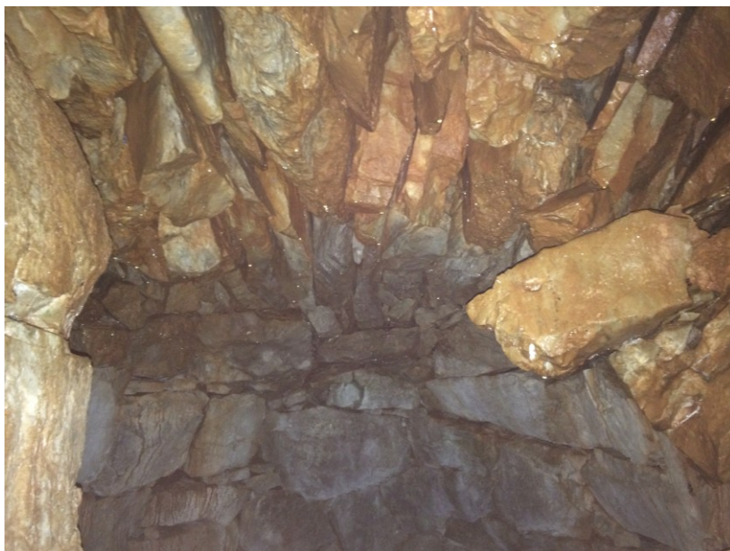
Strop iz navpično zloženih klinastih kamnov je oblikovan v obok. Na fotki desno spodaj je vidna praznina zaradi izpadle skale (foto MF).
